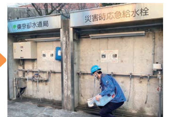
▲ 災害時はシャッターを開けて、じゃ口から水をくむことができます。
