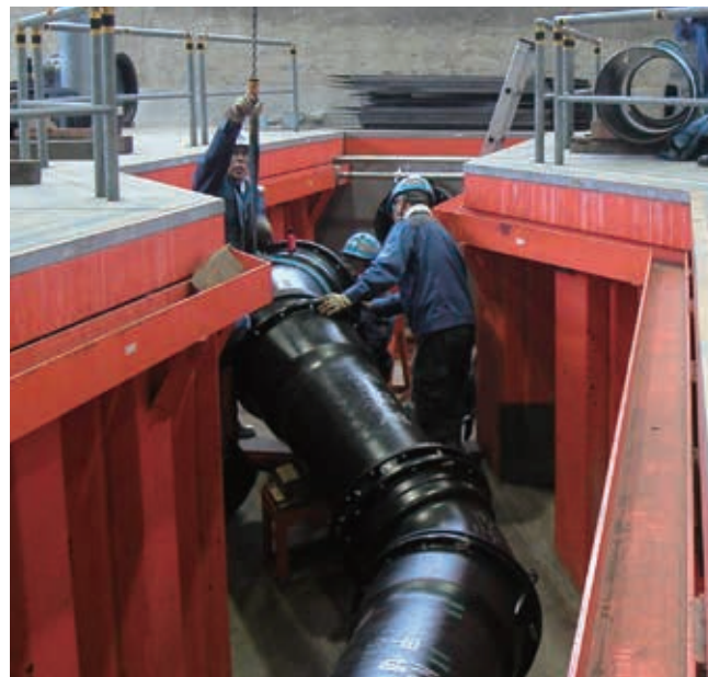
▲ 水道管をつなぎ合わせる作業の訓練
