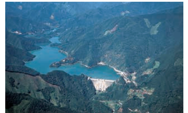
▲ げんざいの小河内ダム（貯水池）
