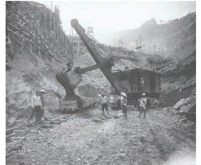
▲ 小河内ダムの建設現場（昭和17年）
